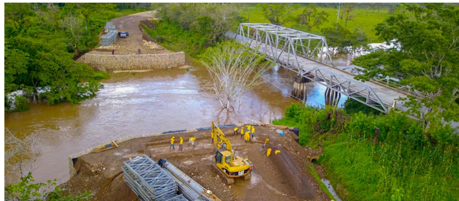
Instalación de puente tipo bailey en Km. 313 CA-13, Aldea La Libertad y Modesto Méndez, Izabal.
