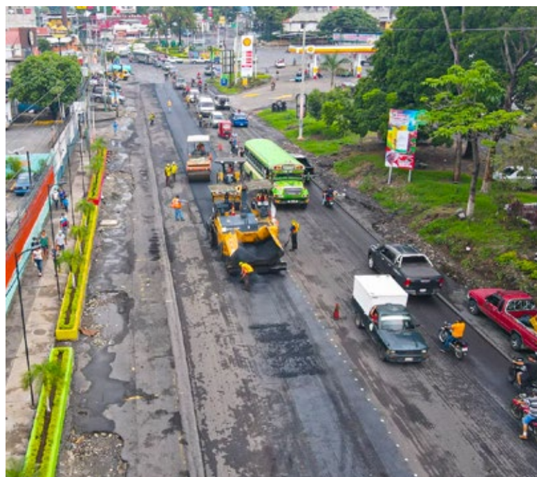
Colocación de nueva carpeta asfáltica en la CA-09 Sur, Km. 59 en ruta que conduce de la cabecera departamental de Escuintla a Masagua.
