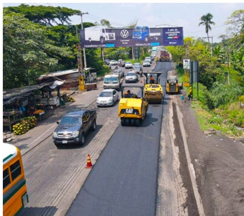
Colocación de nueva carpeta asfáltica en la CA-09 Sur, Km. 59 en ruta que conduce de la cabecera departamental de Escuintla a Masagua.
