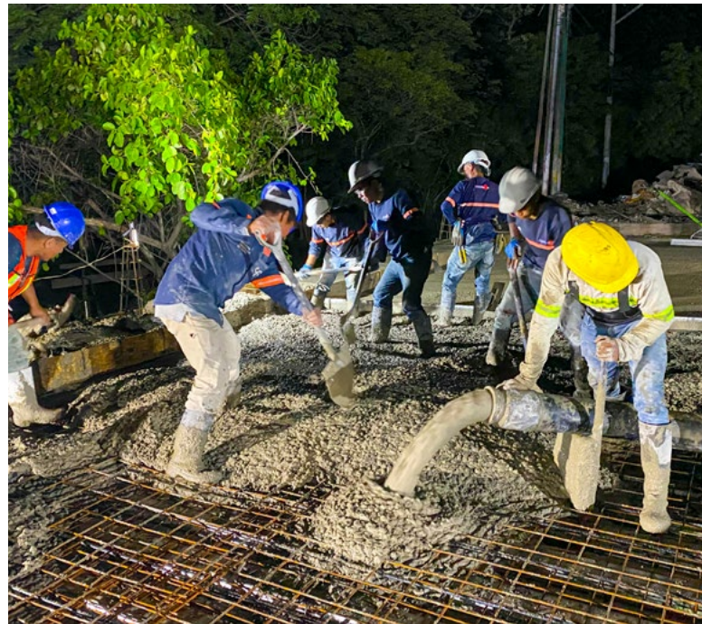
Trabajos de relleno estructural de los aproches del Puente Petapilla en el Km. 163.9 de la CA-10, Chiquimula.
