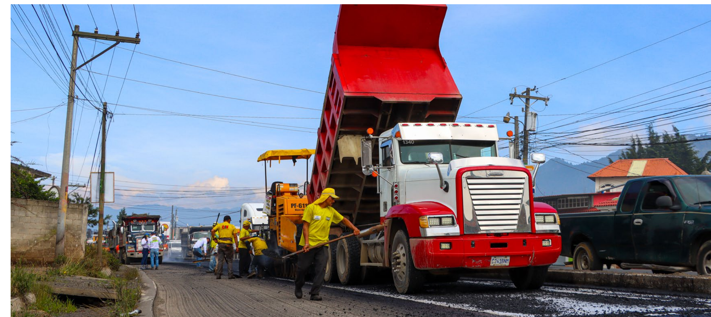
Trabajos de recapeo en la ruta que conduce de San Juan Ostuncalco a Xela, Quetzaltenango.
