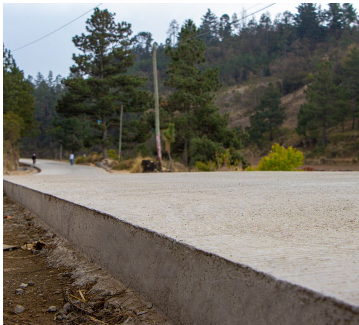
Aplicación de concreto hidráulico en la ruta de San Carlos Sija y Sibilia, Quetzaltenango.
