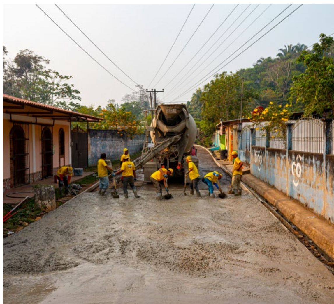
Pavimentación con concreto hidráulico en la ruta de ingreso a la Aldea Cayuga en Morales, Izabal.
