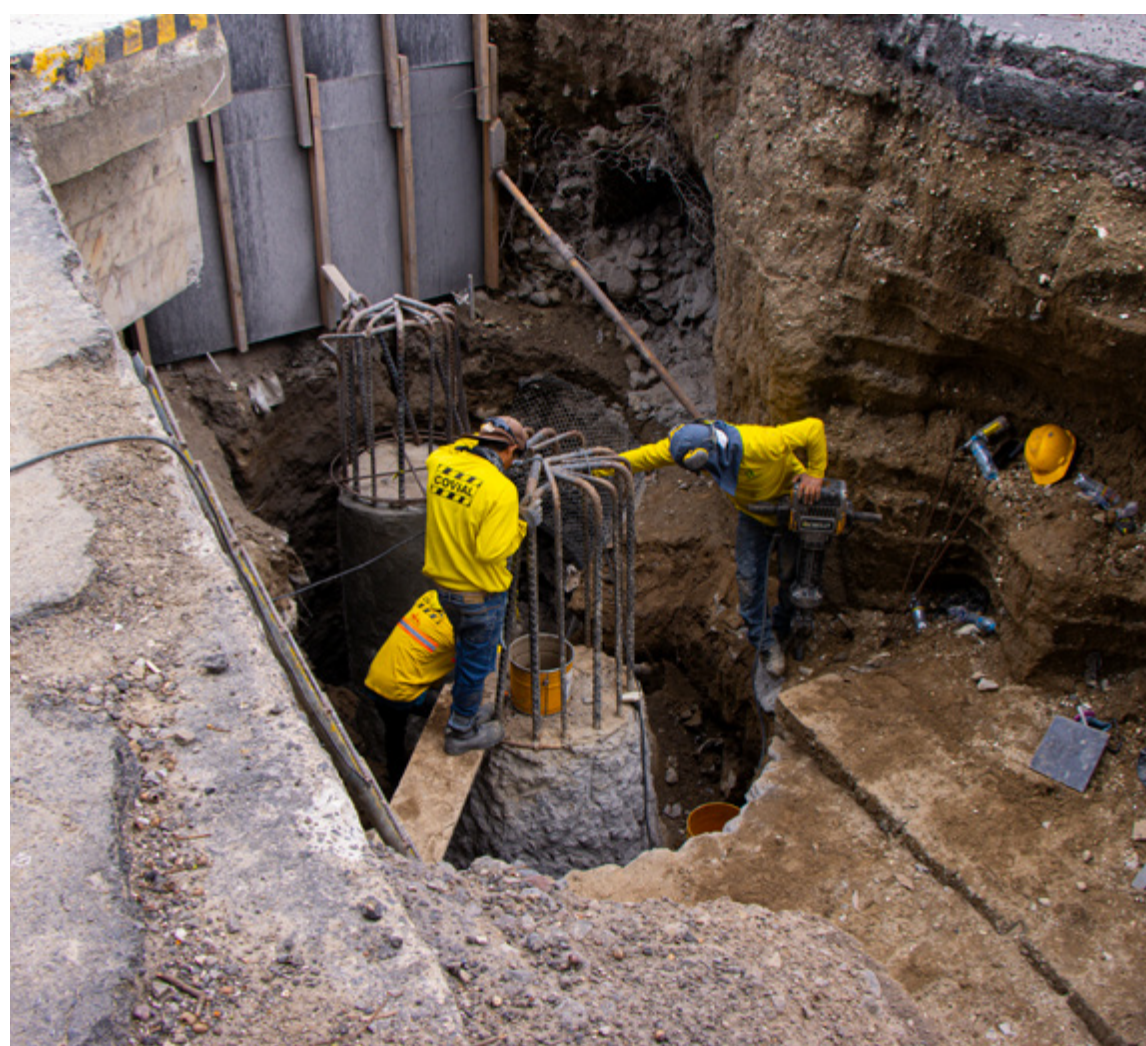
Finalización de los trabajos de cimentación en el Puente Villalobos I, CA-09 Sur, Villa Nueva, Guatemala.
