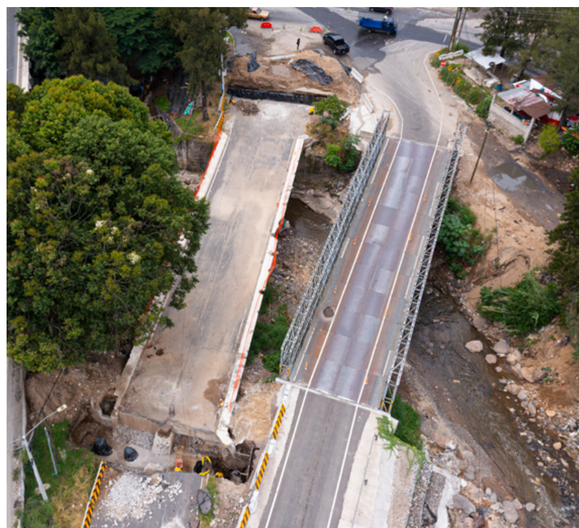
Finalización de los trabajos de cimentación en el Puente Villalobos I, CA-09 Sur, Villa Nueva, Guatemala.
