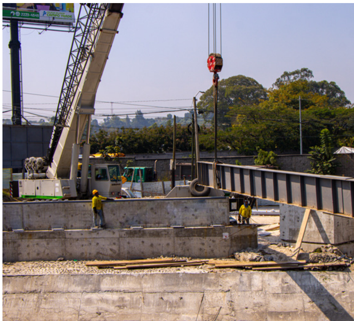
Instalación de vigas longitudinales en el Puente Tubac, Villa Nueva, Guatemala.
