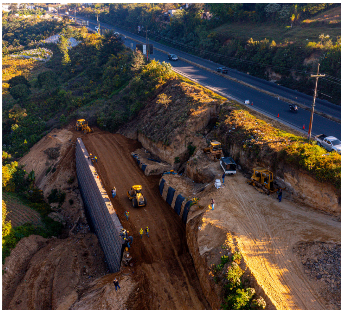
Construcción de muro de retención de suelo, estabilizado mecánicamente con geosintéticos del Km. 44.1 de la CA-01 Occidente, Sacatepéquez.
