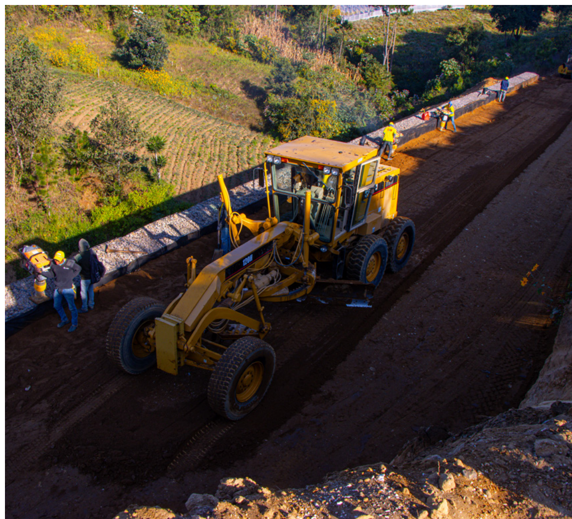
Construcción de muro de retención de suelo, estabilizado mecánicamente con geosintéticos del Km. 44.1 de la CA-01 Occidente, Sacatepéquez.
